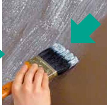
**上塗り** 刷毛先1/3以内に塗料を付け、刷毛と壁面の角度を45度以内に保ちながら矢印方向に配ってください(1回のストローク:15~20cm)。これを繰り返し、塗料中に含まれる粒子を壁面に均等に配っていきます。
