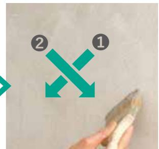
**仕上げ** 刷毛と壁面の角度を45度以内に保ちながら①②の順に矢印方向へランダムに配り、塗り重ねは塗料が乾く前に行ってください(1回のストローク:10~15cm)。
