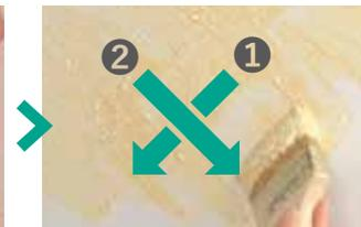
**上塗り** 刷毛先1/3以内に塗料を付け、刷毛と壁面の角度を45度以内に保ちながら、粒子を均一に①②の順に矢印方向ヘラシタムに配ります(塗り重ねは少なく、1回のストローク:10~15cm)。大面積の場合、壁面1.5~2m位の間隔で塗付量の均一性を確認してください。塗料が少ない場合は追加し、多い場合は刷毛先で取り除いてください。
